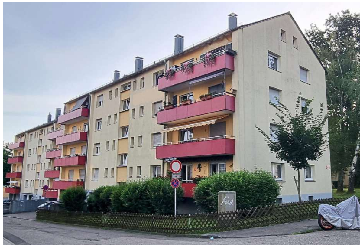
Im Objekt Ooser Waldstraße wurde mit dem Austausch veralteter Heizungstechnik begonnen. Foto: Baugenossenschaft Familienheim Baden-Baden eG
