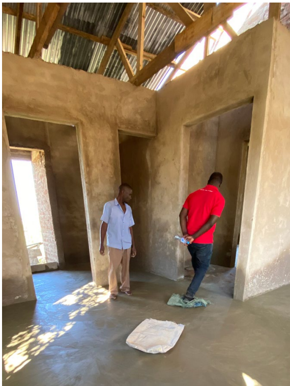
Estrich gießen im Hausinneren.
