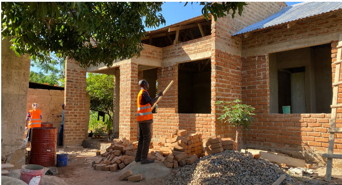
Praktische Mauerausbildung direkt an neuen Häusern.
