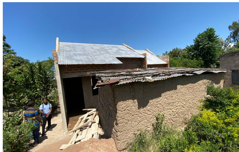
Alte Wohnhütte im Vordergrund, neues Haus im Hintergrund.
