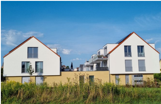
Mietwohnhaus Kuppenheimer Straße 26/Pflostweg 31
