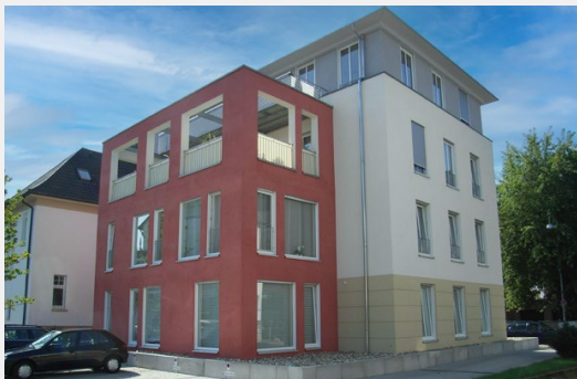
Wohn- und Geschäftshaus Ooser Bahnhofstraße 17 a
